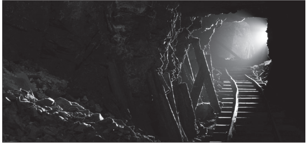
Lange Tunnel werden üblicherweise im Gegenortvortrieb gebaut ...
